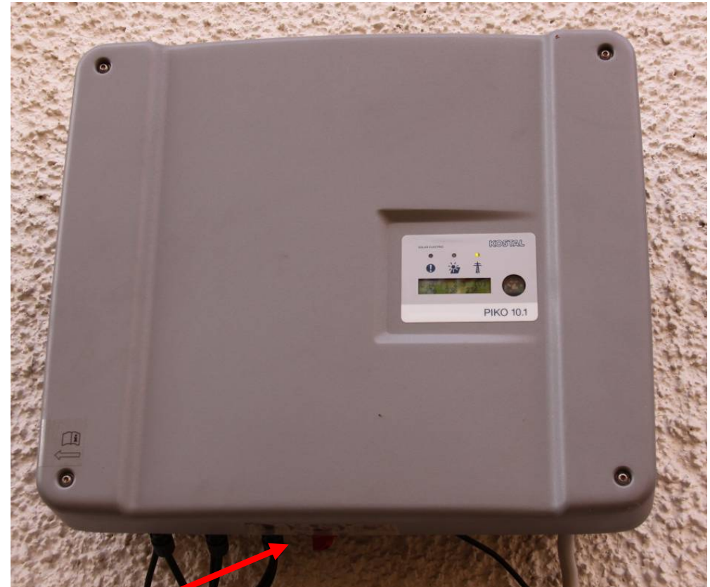
Wechselrichter der Fa. Kostal
